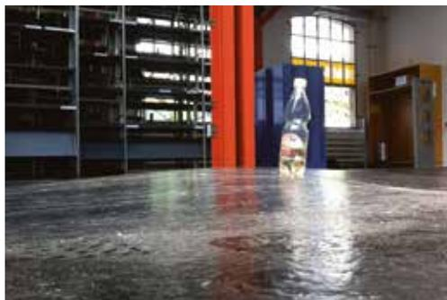
Zum x-ten Mal musste der Fussboden wegen gefährlicher Bodenwellen saniert werden. Das hiess, alle Gestelle leeren und wieder einräumen.
